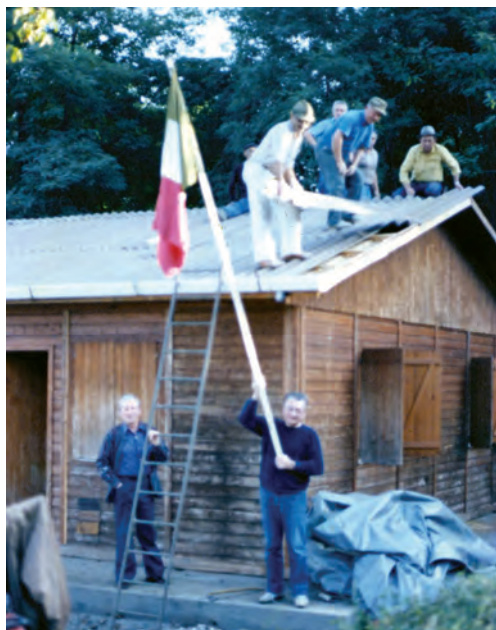
Antonio Binda sventola il Tricolore per festeggiare il completamento del tetto della nuova Sede del Gruppo
